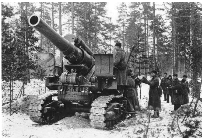
Obusier soviétique de 203 mm (modèle 1931). Conçu à partir de 1926, il fût produit en série à partir de 1932 à 850 exemplaires (dont 85 % au cours de la seule période 1939-1941). D'un poids de 100 kg, son obus possédait une vitesse initiale de 607 m/s pour une portée maximale de 18 km. Surnommé "le marteau de Staline" par les nazis, il fût surtout utilisé pour briser les plus lourdes fortifications ennemies du fait de sa faible cadence de tir (jusqu'à 1 toutes les 2 minutes). Il fût notamment utilisé dans les rues de Berlin pour détruire les bunkers de la Wehrmacht.
