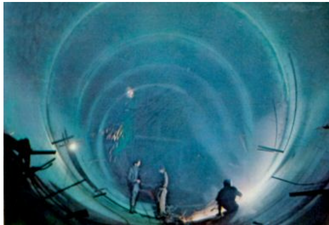
Fierze où est construite la nouvelle centrale hydro-électrique, la plus grande du pays jusqu'à ce jour.
